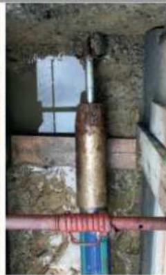
Berstkopf (ll.): vor dem Eindringen in das Altrohr Sprengung (re.): Berstkopf weitet das alte Rohr auf
