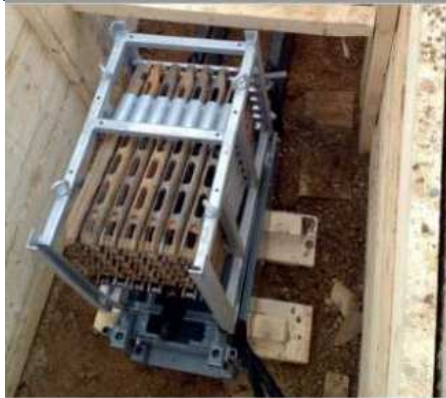
Maschinengrube: ca. 5 m lang, 2 m breit und 2,5 m tief Hydraulisches Bohrgestänge
