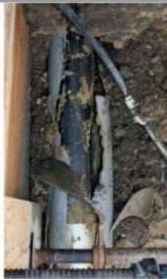
Berstkopf (ll.): vor dem Eindringen in das Altrohr Sprengung (re.): Berstkopf weitet das alte Rohr auf
