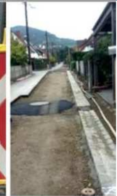
Offene Bauweise (re.): ganzer Straßenzug wurde aufgedaubt – Befahren der Straße und Zufahren zu den Häusern nur zu bestimmten Zeiten möglich
